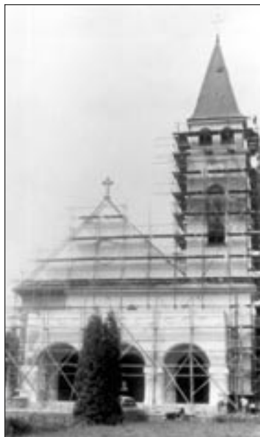
Oprava fasády a věže kostele, rok 1968
